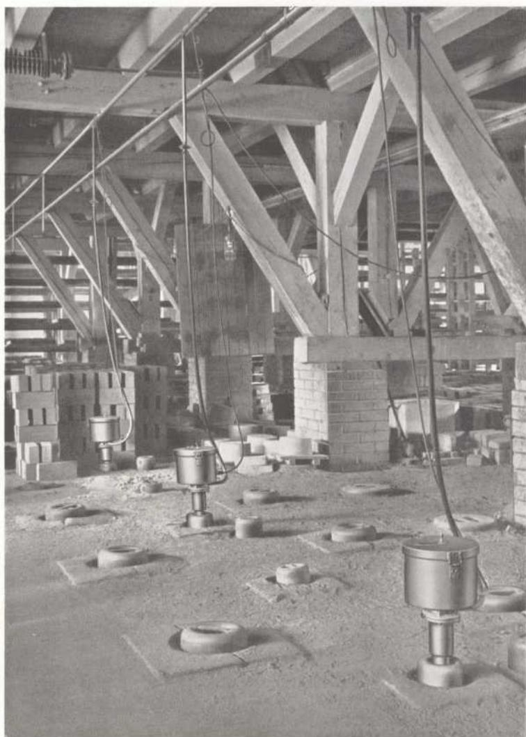
Bild 14. Ardrometer im Deckengewölbe eines keramischen Ringofens.
