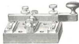
Dieser Taster, mit Federkontakten und Hartgummischuh am Hebel, ist für Arbeitsstrom eingerichtet.
