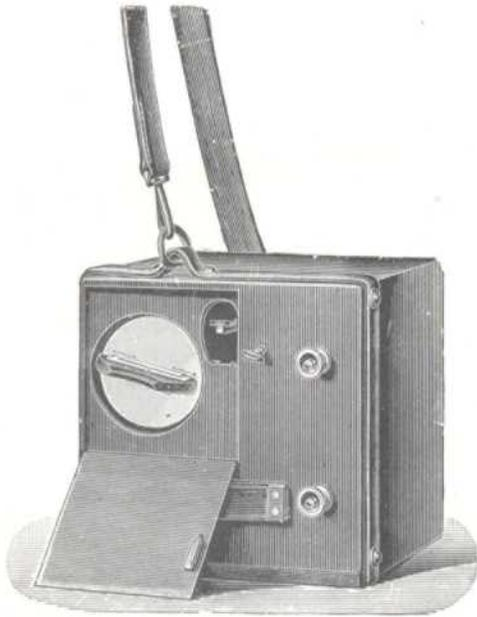
Der Apparat ist eine Weiterentwicklung des von Werner Siemens 1867 angegebenen Minenzünders; er dient zur Entzündung von Glühzündpatronen und findet besonders da Verwendung, wo es sich um eine größere Anzahl gleichzeitig zur Entzündung zu bringender Patronen handelt.
