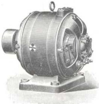
Der Motor besitzt ein zweipoliges, gegossenes Magnetgestell runder Form mit zwei angeschraubten Lagerschildern. Die Lager sind mit Ringschmierung ausgerüstet. Der Anker besteht aus genuteten Blechscheiben und ist mit Oberflächen-Schablonenwicklung versehen.
