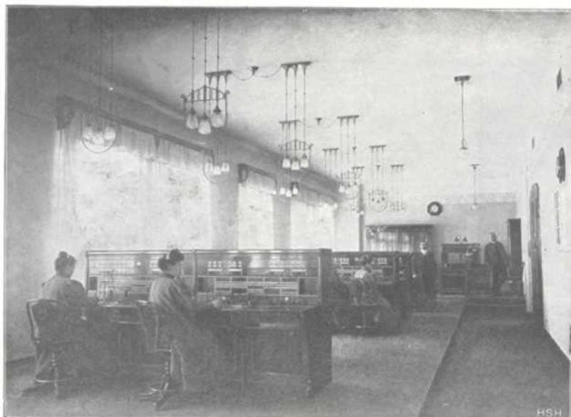
Fernamt neuester Konstruktion ist das von der Firma Siemens & Halske A.-G. errichtete und zu Beginn des Jahres 1906 in Betrieb genommene Fernamt Nürnberg, an das beim völligen Ausbau 240 Fernleitungen angeschlossen werden können.
